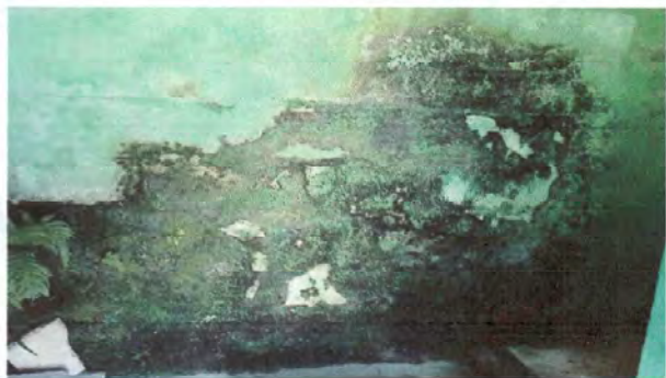
Foto 1: Impermeabilización de losa.
