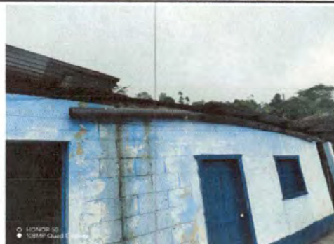
Foto 2: Cubierta de lámina.
