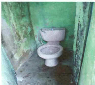
Foto 3: Sustitución de inodoro.
