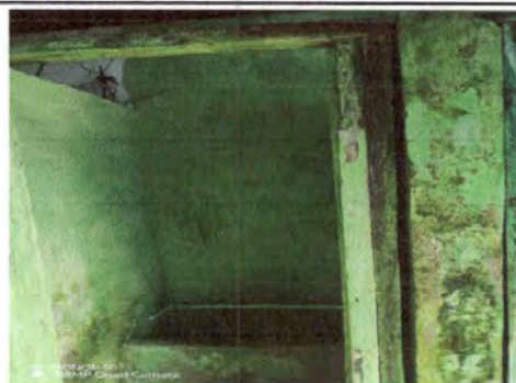
Foto 4: Sustrución de azulejo a la pared.
