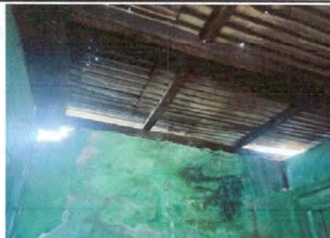
Foto 2: Sustitución de láminas.
