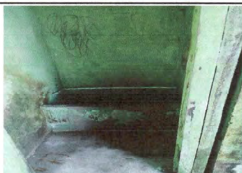
Foto 5: Sustitución de mingitorio.
