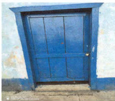
Foto1: Sustrución de puerta.
